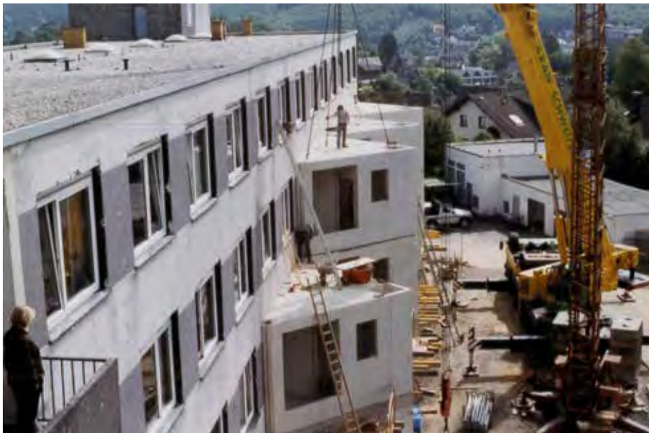
Mit den dreieckigen Anbauten bekommt das Ev. Krankenhaus Bethesda seine charakteristische Rückansicht. Gleichzeitig wird der Gebäudeteil um eine Etage aufgestockt.
