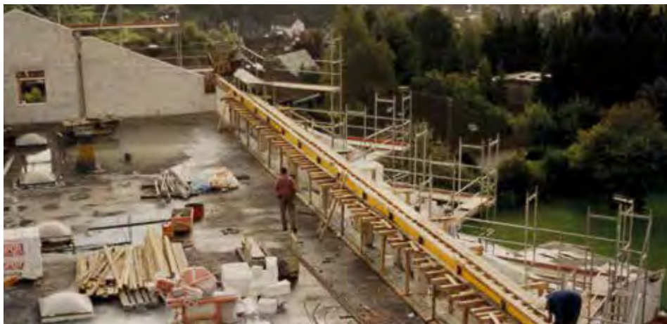
Der ursprüngliche Teil des Neubaus wurde aufgestockt und um sogenannte Erkanassen erweitert.
